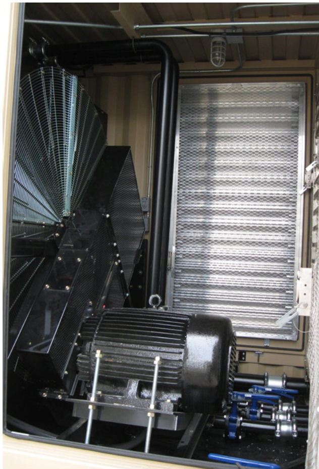
Radlator Fan Motor (480V)
